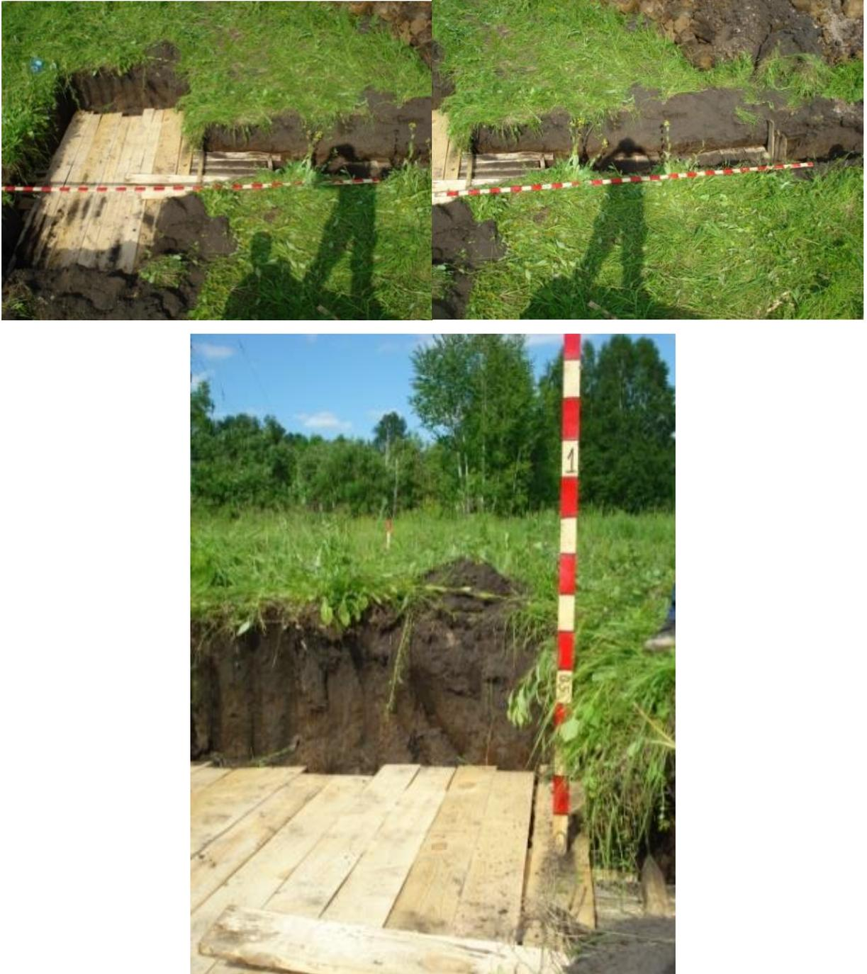
Рисунок 16 – Землянка (комната  $2 \times 2 \text{ м}^2$ , коридор  $1 \times 3 \text{ м}^2$ ), крыша на глубине 1.0 м, глубина землянки 1.5 м
