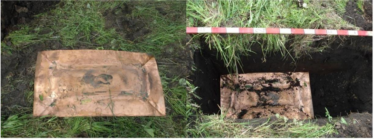
Рисунок 29 – Горизонтальный медный лист  $0.5 \times 0.6 \text{ м}^2$ , глубина заложения 0.2 м
