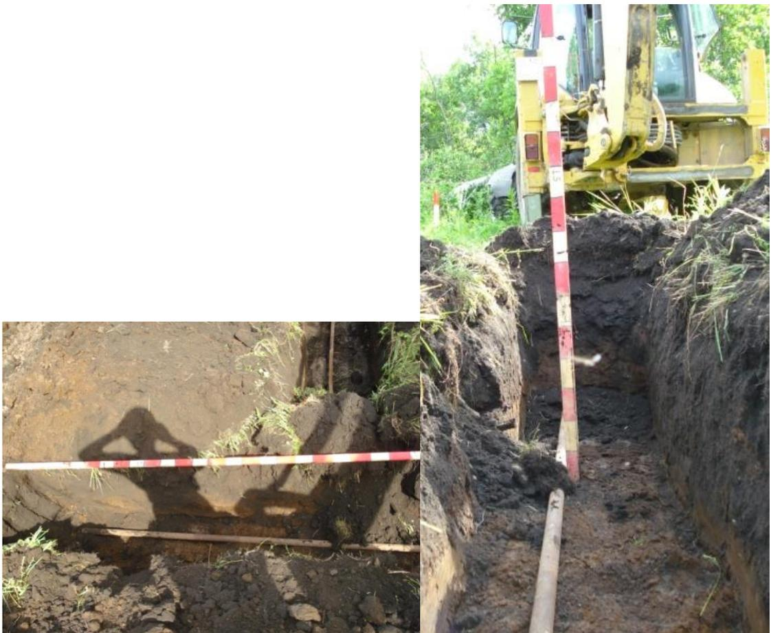
Рисунок 32 – Стальная труба длиной 3 м,  $D = 42$  мм, глубина заложения 0.65 м
