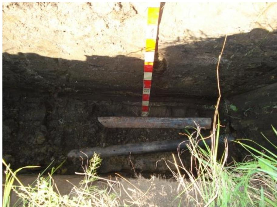
Рисунок 7 – «Зенитные снаряды» – обрезки круглого металлического бруса длиной 1.1 и 0.7 м,  $D = 70$  мм, лежат рядом, параллельно друг другу, глубина заложения 1.5 м
