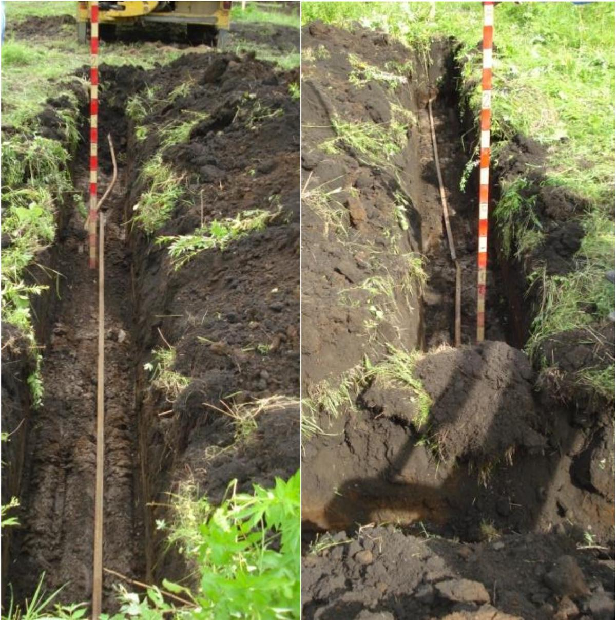
Рисунок 33 – Стальной брусок длиной 7.5 м, сечение  $20 \times 30 \text{ мм}^2$ , глубина заложения 0.7 м
