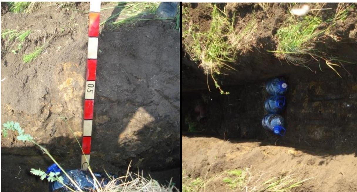
Рисунок 5 – Пластиковые бутылки 3 шт. (5 л) с металлической стружкой, глубина заложения 0.8 м
